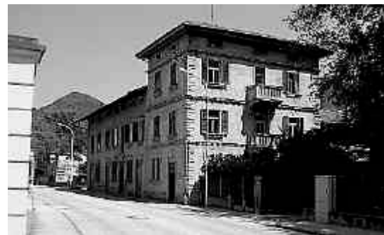
Il palazzo Maoro in via Regensburger che sarà sottoposto a ad un radicale restauro e trasformazione
